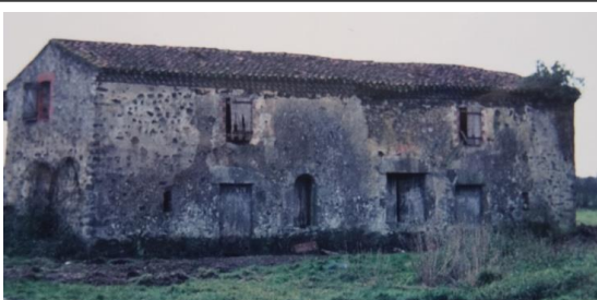
La maison des maîtres de la Basse Normandelière. Elle serait du XII ème siècle. Depuis le 18 ème siècle, lorsque qu'une nouvelle maison des maîtres fut construite, elle est utilisée pour entreposage des produits de la ferme
